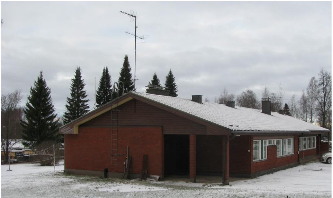
Kuva 4. Pappilarakennus etelän suunnasta kuvattuna (Valokuva Ympäristönsuunnittelu Oy, 26.11.20213).
