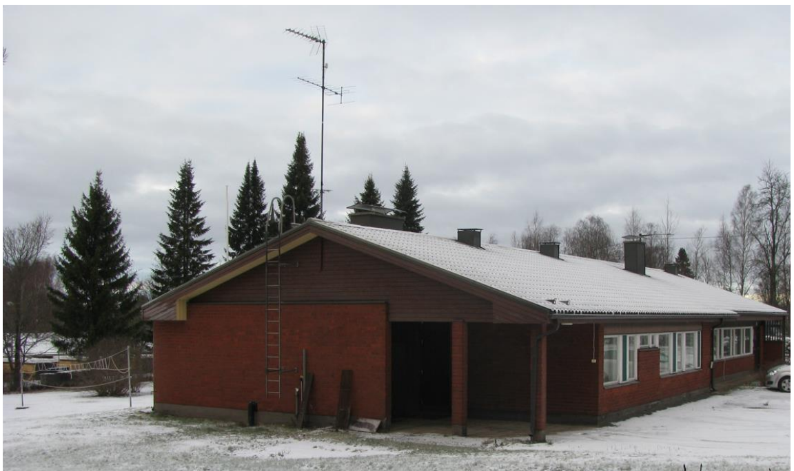
Kuva 4. Pappilarakennus etelän suunnasta kuvattuna (Valokuva Ympäristönsuunnittelu Oy, 26.11.20213).
