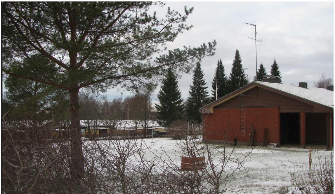
Kuva 6. Pappilarakennuksen eteläpääty ja piha-alue. Taustalla näkyy suunnittelualueen länsipuolella Salmiontien varressa sijaitseva rivitalo. (Valokuva Ympäristösuunnittelu Oy, 26.11.20213).
